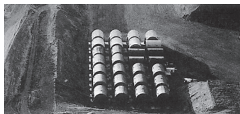
Рис. 4. Размещение реакторных отсеков в котловане
