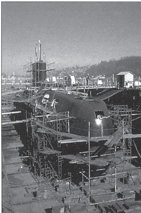
Рис. 11. Ремонт подводной лодки на верфи компании ASMAR
